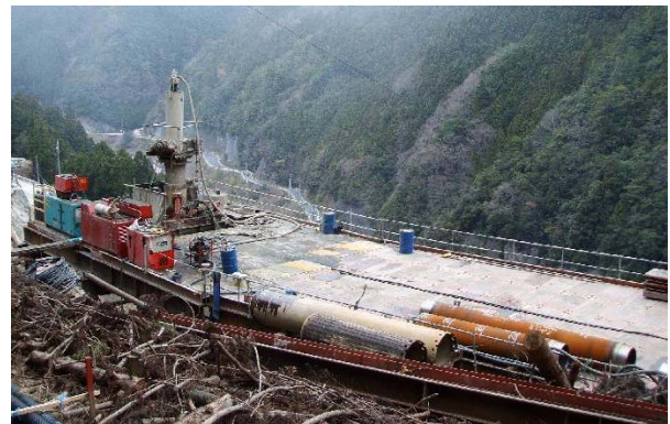
全体施工状況(栈橋上での抑止杭削孔)
