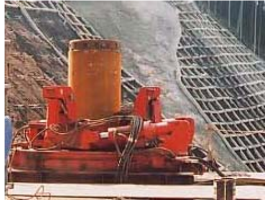
半揺動(チュービングジャッキ)でケーシングチューブ掘削
