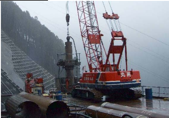
中掘ダウンザホール削孔状況
