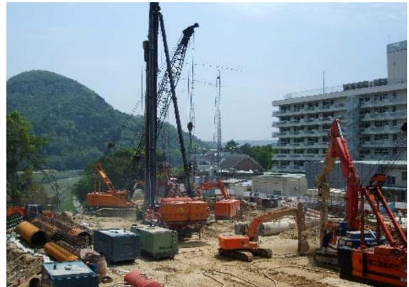
狭い作業ヤードで5セットの掘削機が稼動
