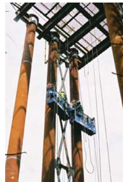
ゴンドラ足場
