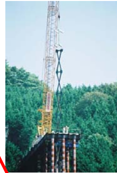
支柱補強材吊り込み
