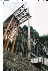
鋼管杭打設
