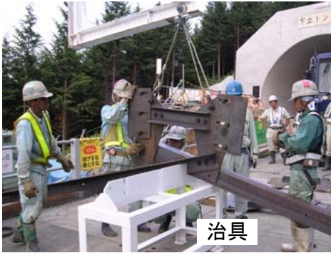
支柱補強材組立て状況
