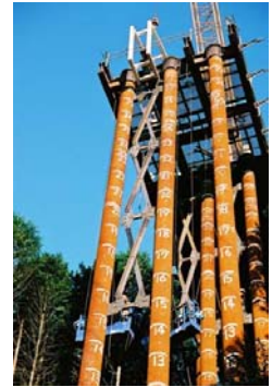
杭間建て込み
