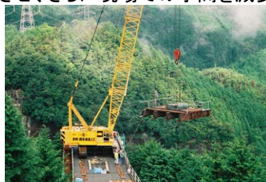
上部パネル組立、建て込み
