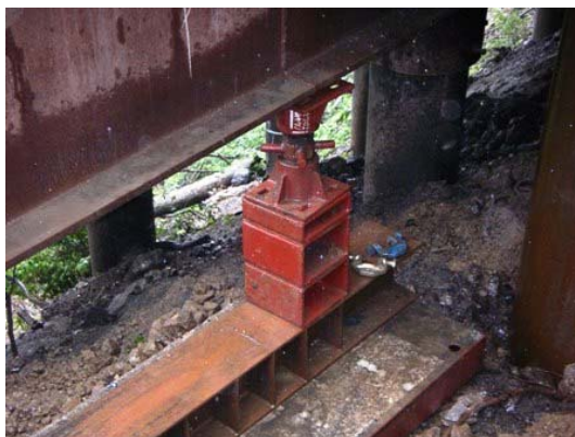
ケーシング引抜時240t荷重がかかり構台をキリンジャッキにて補強
