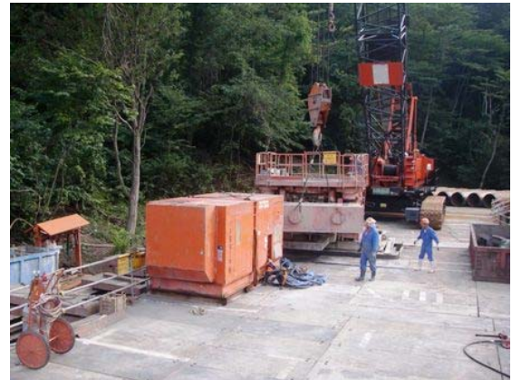
機種RT2000施工状況
