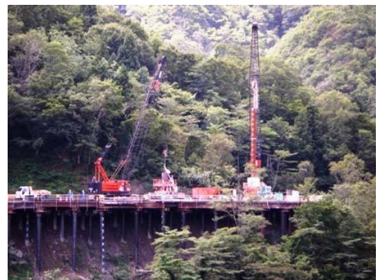
抑止杭施工全景
