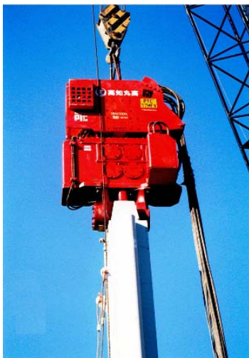
打込機(PTCバイブロフォンサー)
