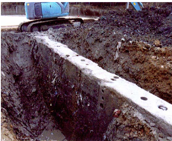
遮水壁出来形
