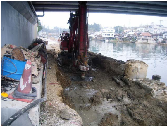
橋桁下施工状況
