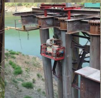
ワンタッチ伸縮梁取付 ゴンドラ足場
