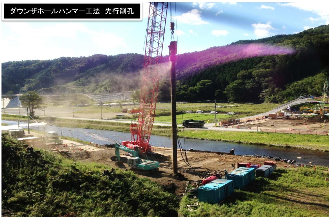
矢板箇所では、玉石の多い硬質地盤で、パイロのみの打設は不可能で、鋼矢板用ダウンホールハンマー工法で先行削孔を行う。
