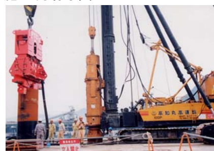
施工現場写真(大型バイブロフォンサー)
