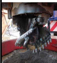
コニカル拡大 圧入工法
