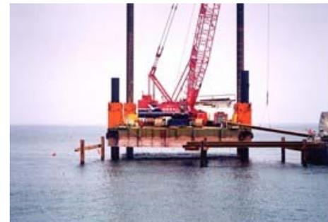
油圧ジャッキにて杭打機台船を波高さより上にジャッキアップし、安定させ高精度の作業を可能とした作業船
