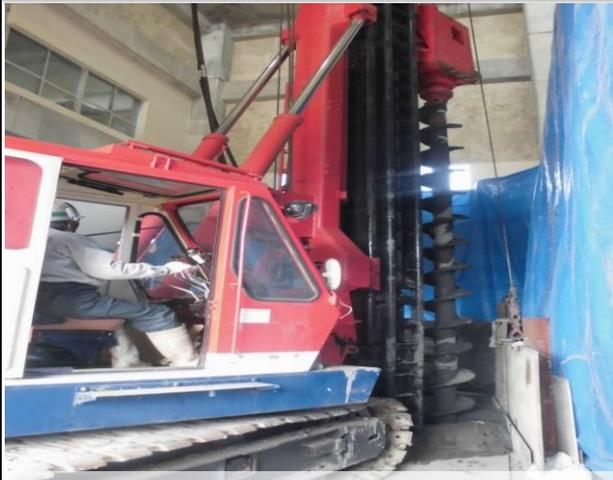
低空間杭打機による先行削孔
