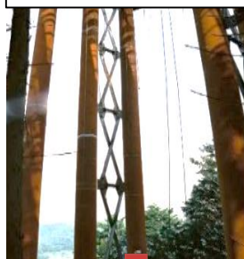
⑤ワンタッチ伸縮梁を吊込む
