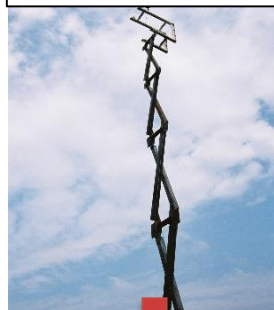
④ワンタッチ伸縮梁を連結
