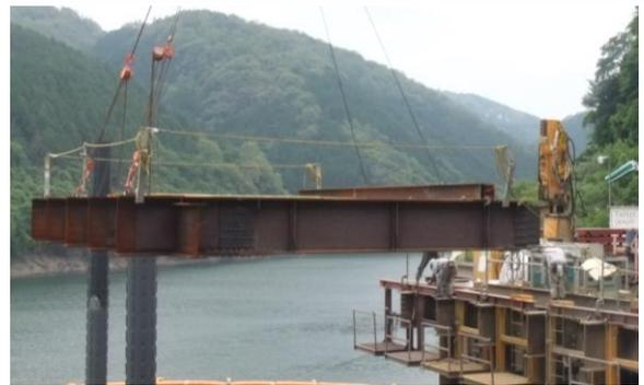
ステップブリッジは、SqCピア工法上部パネル式における多くの施工実績から培った経験を応用し、**永久橋として利用できるように改良した鋼管杭橋である。**SqCピア工法上部パネル式の利点を応用し、上部工を先行架設し、張出された上部工に取付けられた杭頭キャップをガイドに杭施工し、覆工板を設置した後、到達側より後退しながら、覆工板を撤去、コンクリート床版を設置した後、本橋として完成。導杭・導材・導枠は一切不要となっており、手延べ工法で施工するため、山岳部等の急峻な地形や水上施工でも仮設等が必要なく、工期・工費縮減及び安全性を確保、災害時の復旧橋として威力を発揮することができ、**仮設栈橋として使用後、本橋として、そのまま存置・使用が可能。**
