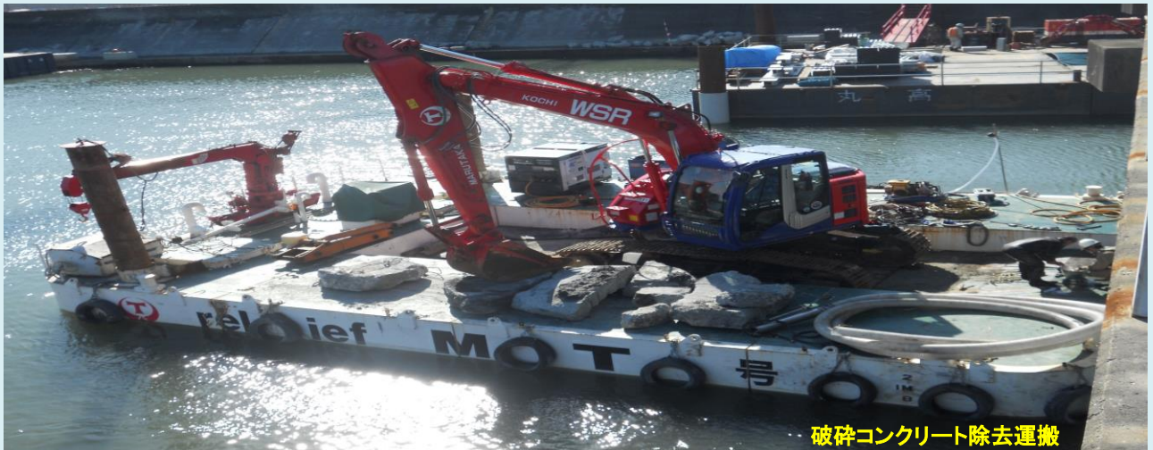
組立式自航艇 水中ブレードクラッシャーによる コンクリート破砕
