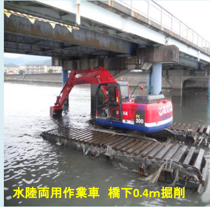
浚渫工事 泥土固化済 攪拌
