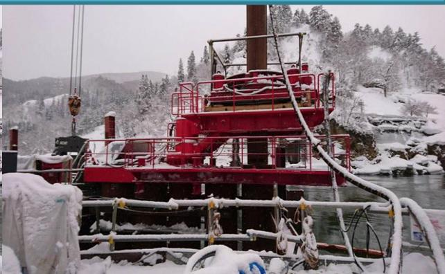
架台 全周機ダウンザ併用架台
