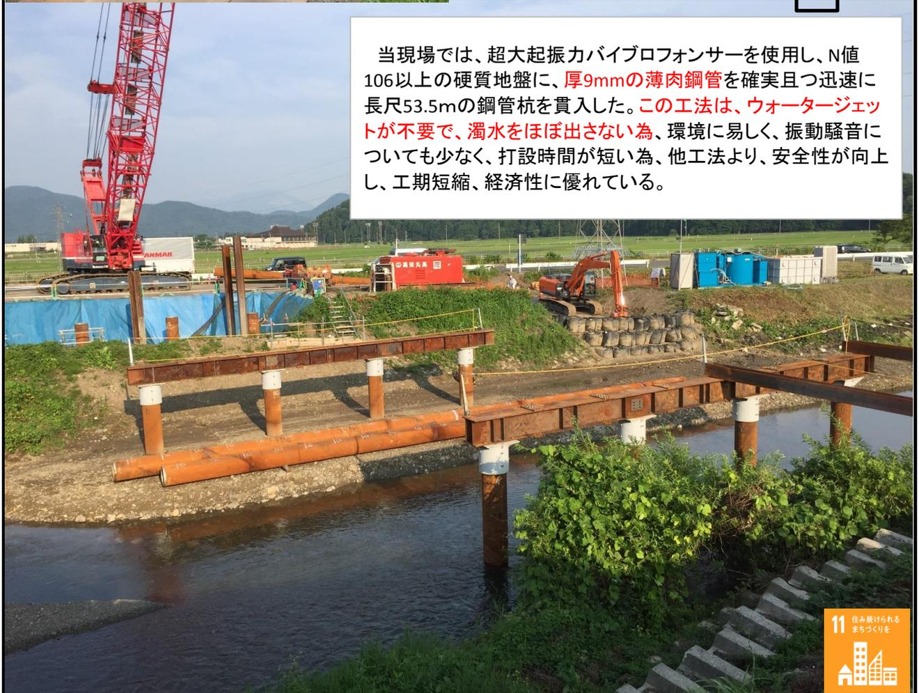
当現場では、超大起振力バイブロフォンサーを使用し、N値106以上の硬質地盤に、厚9mmの薄肉鋼管を確実且つ迅速に長尺53.5mの鋼管杭を貫入した。この工法は、ウォータージェットが不要で、濁水をほぼ出さない為、環境に易しく、振動騒音についても少なく、打設時間が短い為、他工法より、安全性が向上し、工期短縮、経済性に優れている。
