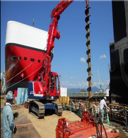
①リーダーレス掘進機 (RX2300) で 先行試掘(φ600 L=15m)
