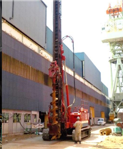
②リーダー式掘進機 (DHJ-40) で先行試掘(φ600 L=15m)
