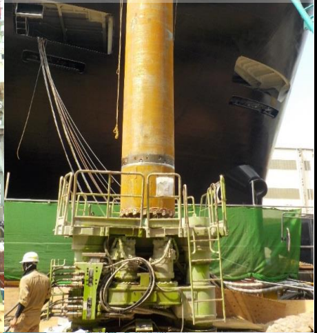
③全旋回オールケーシング (φ1500級 L=15m)で障害物撤去
