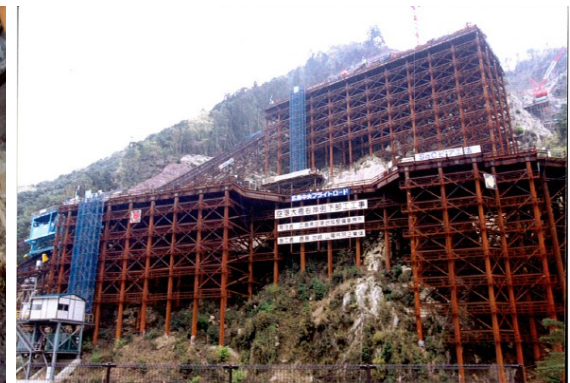
傾斜角34～38度 構台施工
