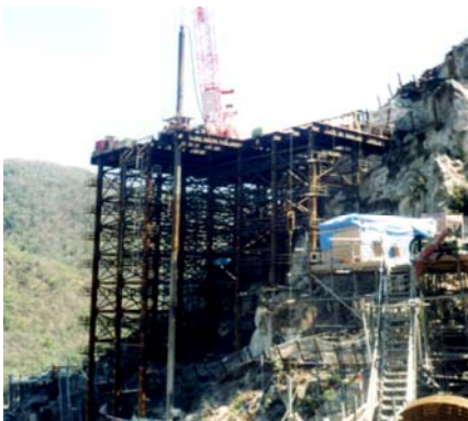
施工前(むき出しの岩に杭を打つ)
