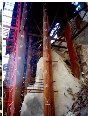
橋脚杭打設完了
