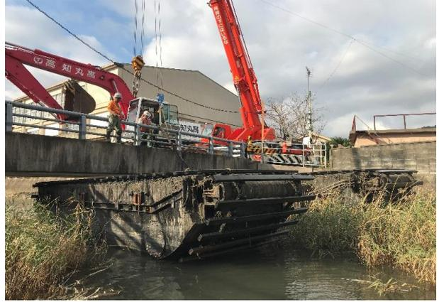
④橋下1.8mフロートキャタのみ通過させる
