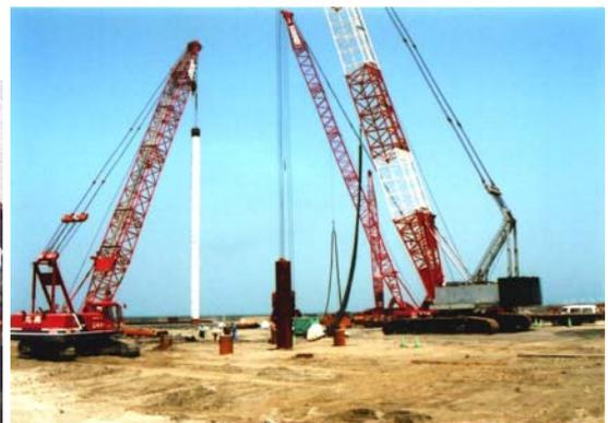
鋼管矢板打込PTCバイプロフォンサー100HD
