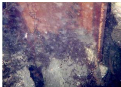
テトラポット H鋼杭貫入状況
