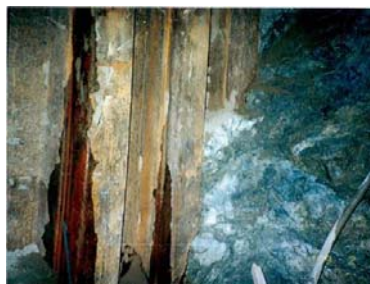
軟岩 鋼矢板貫入状況
