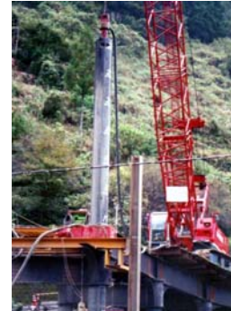
④削孔(ダウンザホール工法)
