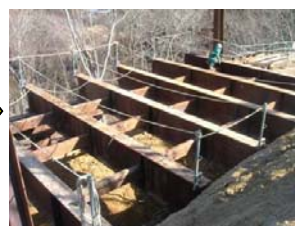
7. 主桁つなぎ取付
