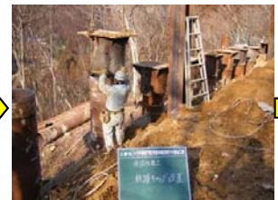
4. 杭頭キャップ取付
