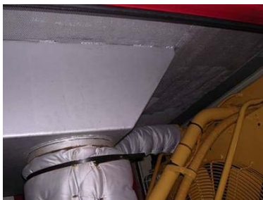
パワーパック内天井
