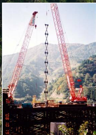
富山県利賀ダム 庄川橋梁下部工事
