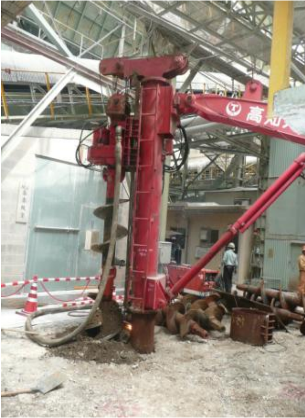
低空頭型杭打機 MH-4 全体図
