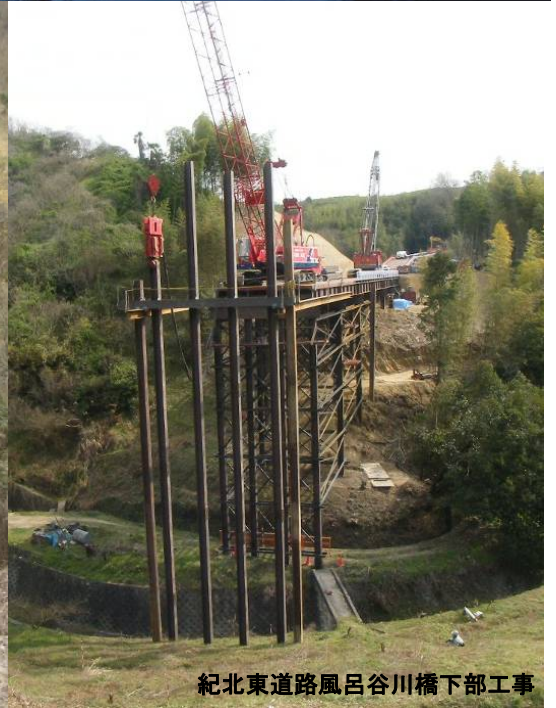
紀北東道路風呂谷川橋下部工事
