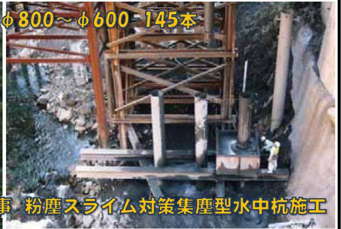
国内 奈良県十津川 SqCピア棧橋工事 粉塵スライム対策集塵型水中杭施工
