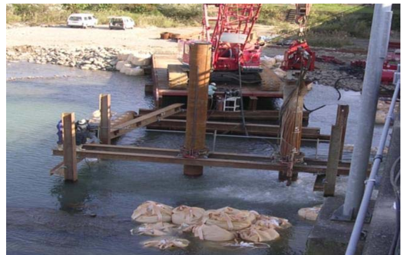
玉石 \phi 200 \sim \phi 600 への水中施工
