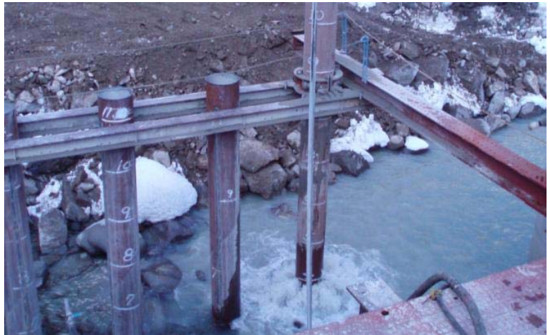
転石 \phi 1000 への水中施工
