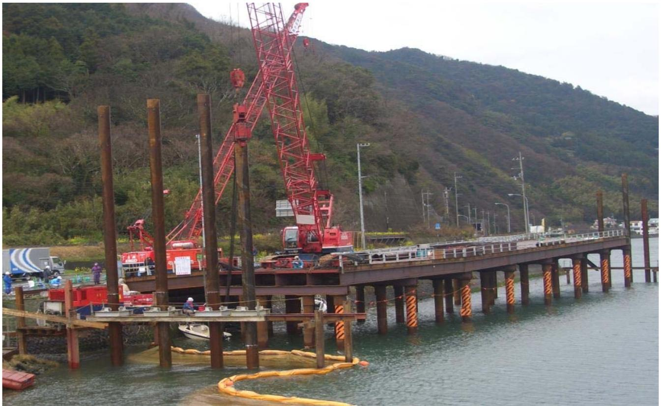
**工法概要-SaCピア鋼管杭キャップ工法**
