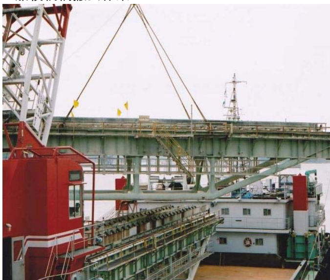
船積栈橋撤去作業
