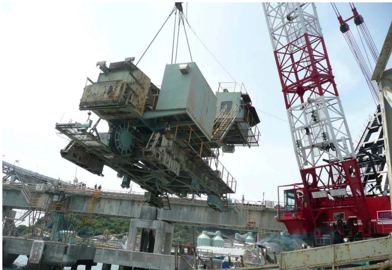
船積栈橋撤去作業
