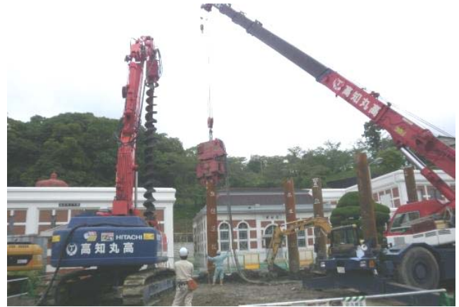
低騒音低振動 超高周波可変式都市型パイロフオンサー打沈 (幅員4m 登栈橋施工予想図)
