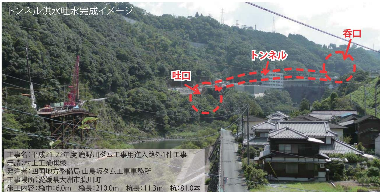
※トンネル洪水吐とは…鹿野川ダムに設置する新しい放流設備で、ダムの貯水池と下流の河川をトンネルでつながる。
