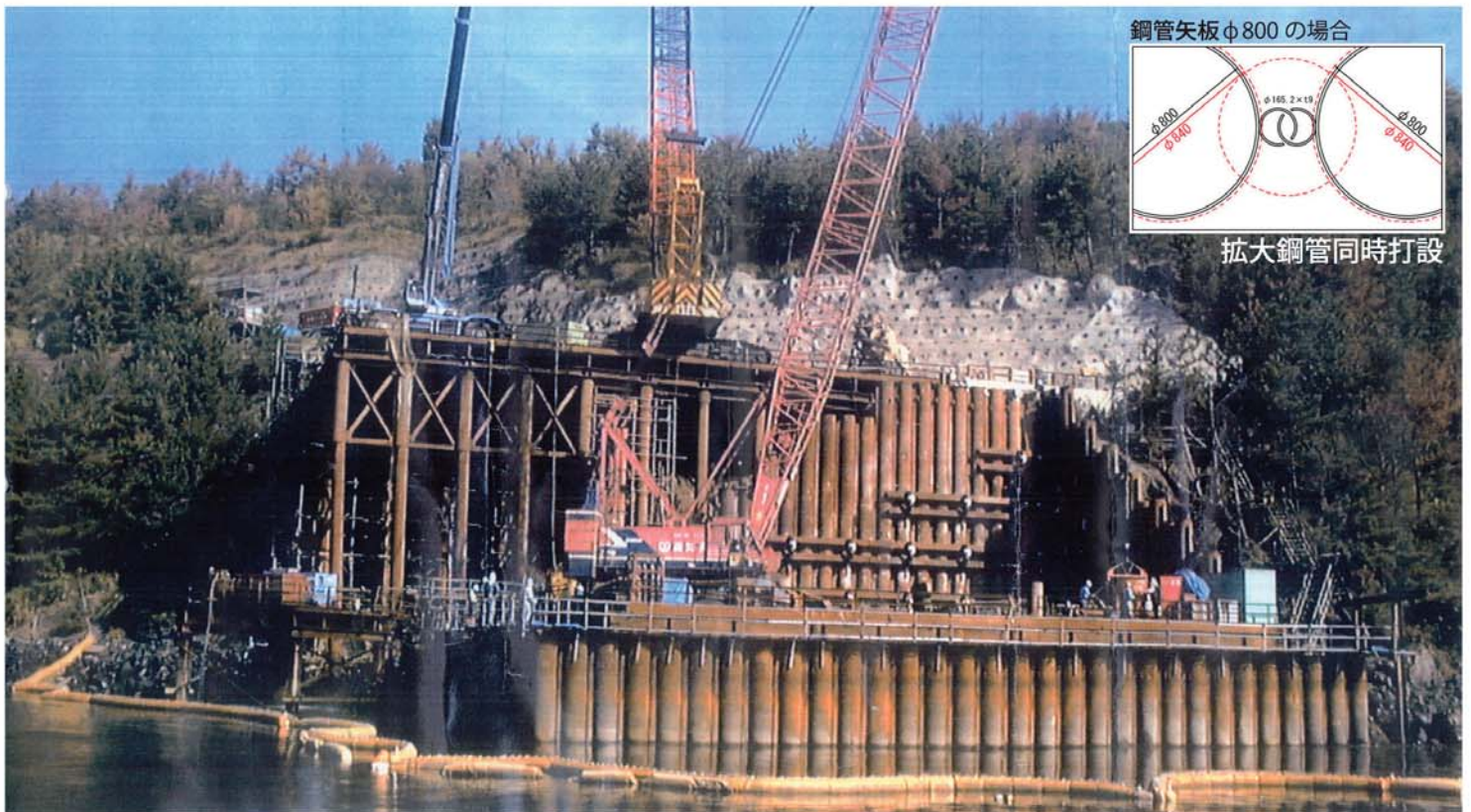
ダウンザホール拡大ビット 鋼管矢板 \phi 1000 の場合
