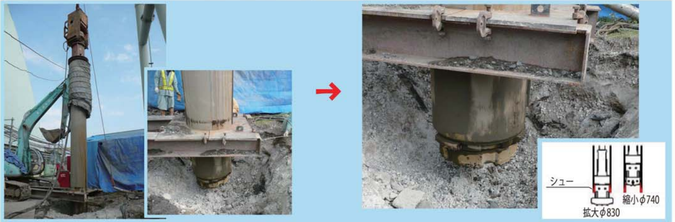
ケーシング継ぎ足し 上杭5.0m
