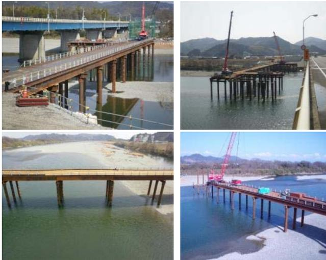
今年1月より施工開始となりました「新仁淀川大橋工事」は、当社開発の鋼管杭棧橋SqCピアキャップ工法を採用して頂いた現場です。
