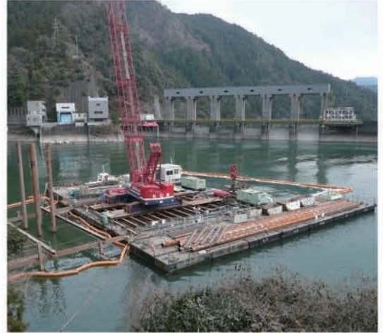
160tクレーン搭載 ダム湖 構台架設
