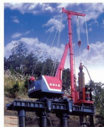
世界最大級パイプソフナー 鋼管杭φ2000打設
