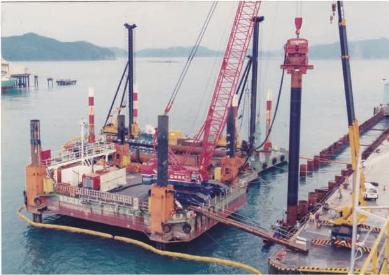
160tクレーン搭載 ダム湖 構台架設
