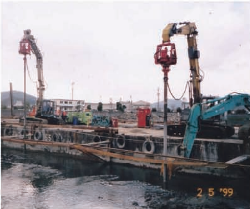
河川での地盤改良
