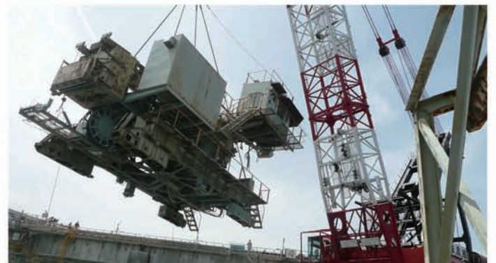
高知県須崎市 日鉄鉱業(株)リフレーマ分解取卸し
