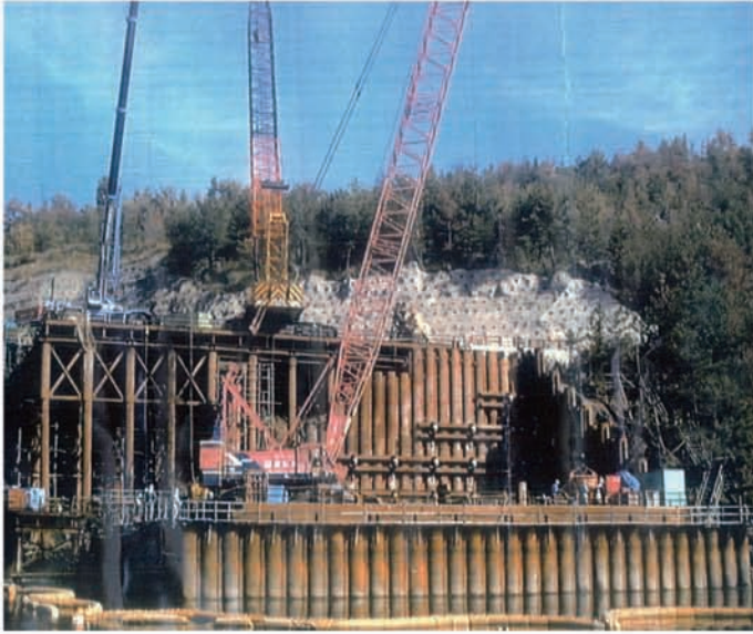
徳島県 加賀須野橋 鋼管矢板 φ800 L= 47.5m
