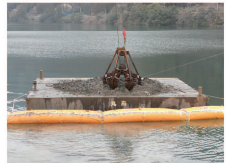
グラブバケット開 土砂集積
