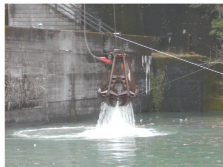
グラブバケット引上げ
