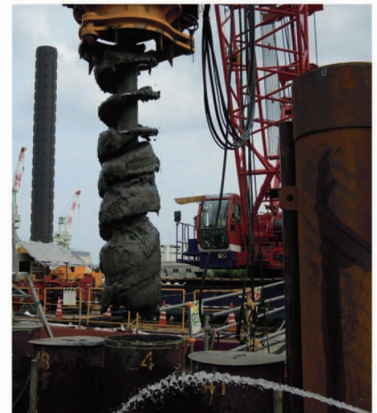
先端スクリュー 土砂掘削φ700
