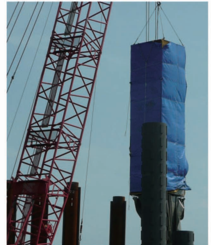
先端スクリュー 土砂掘削φ700
