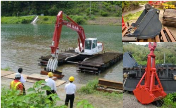
東日本大震災復興支援出動前の動作実験
