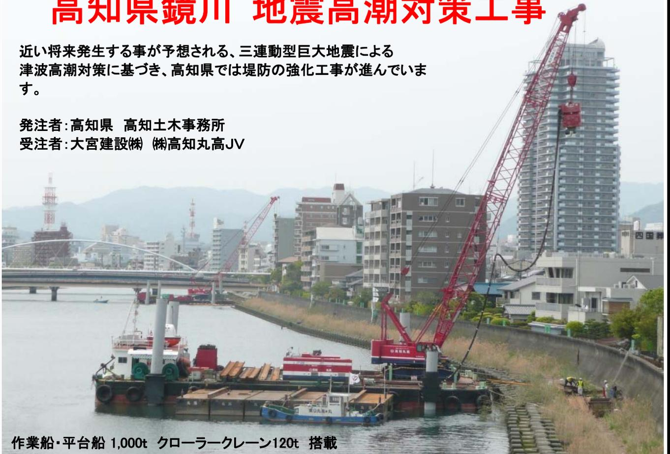
作業船・平台船 1,000t クローラークレーン120t 搭載
