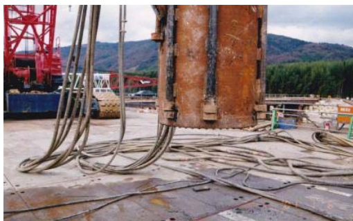
鋼管杭 先行ジェットエア配管
