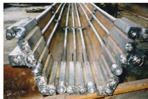
鋼矢板先行ジェットエア配管
