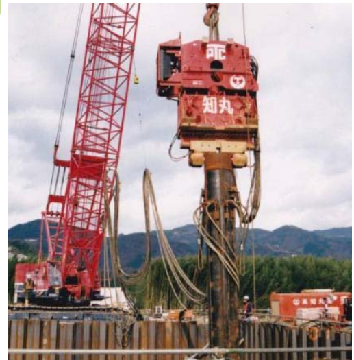
油圧バイプロフォンサー打設 起振力による岩盤破断状況
