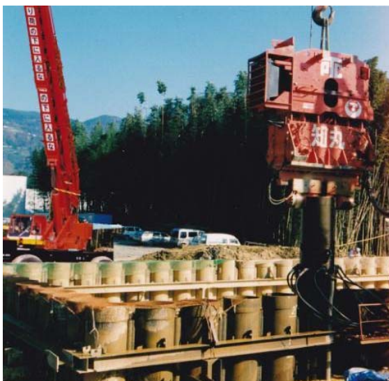
鋼管矢板打設 地質:転石玉石層
