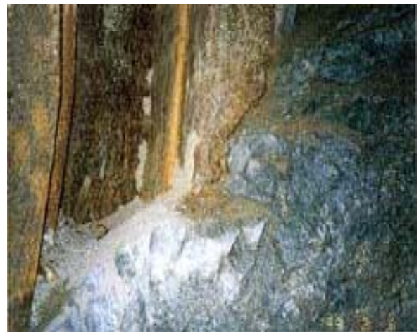
岩盤～鋼矢板 打設状況 岩盤根入 (2.0m)
