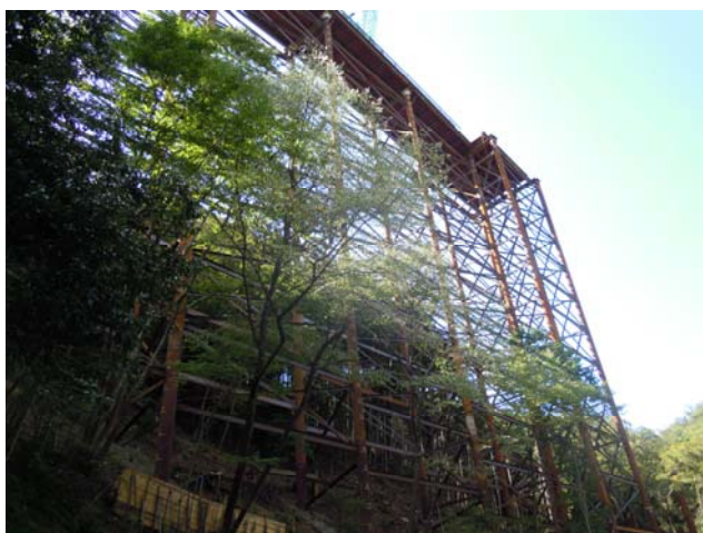
坊川第三橋工事 作業状況
