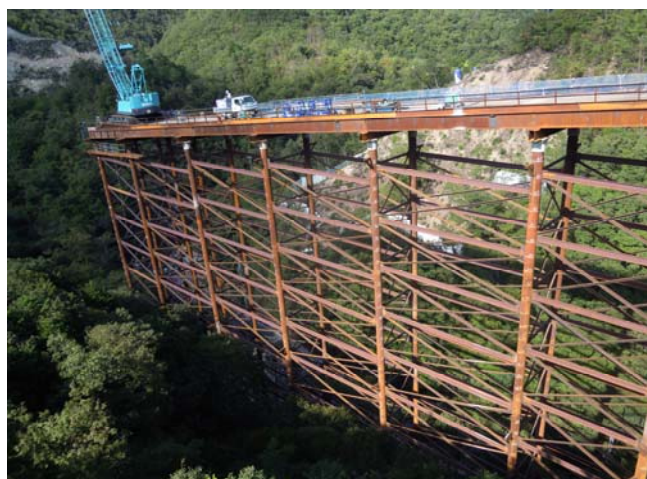
切畑トンネル工事 作業状況
