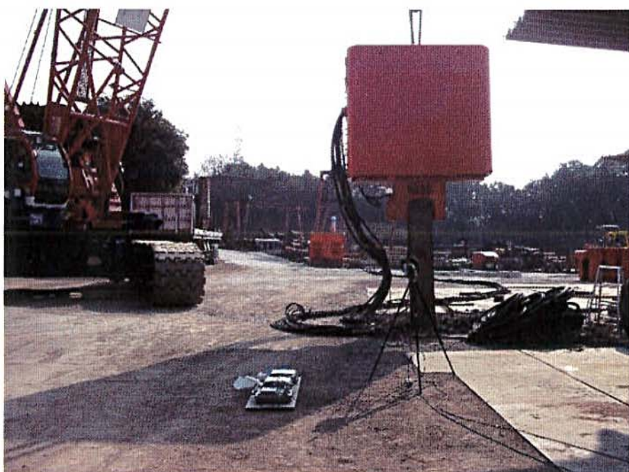
振動騒音測定状況写真
