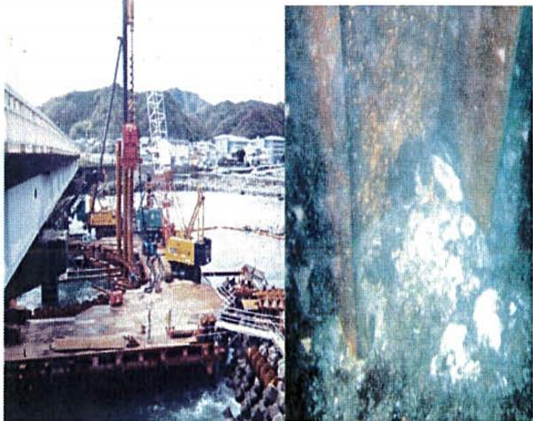
和歌山県/古座大橋
