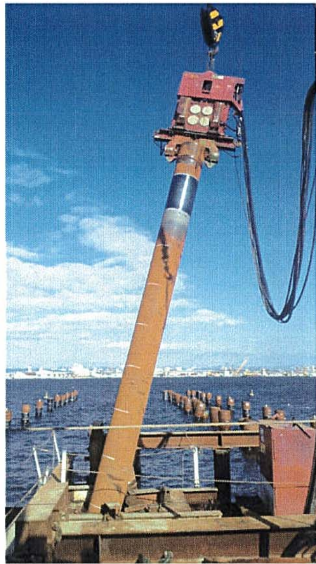
北海道/函館どつく 鋼管杭 \phi 700 斜杭角度 10\sim 15^{\circ}
