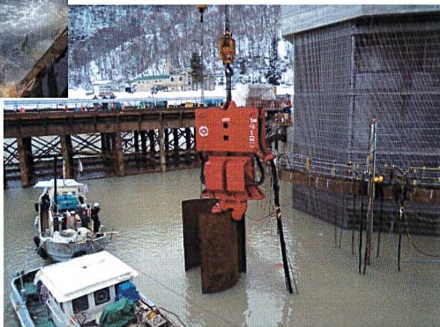
北海道/桂沢ダム 引抜物:鋼管矢板 \phi 2000
