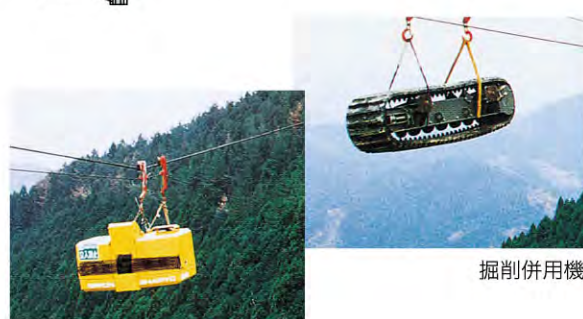
4.9t吊分解 クレーン
