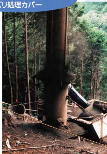
2.鋼管中掘 ズリ処理カバー
