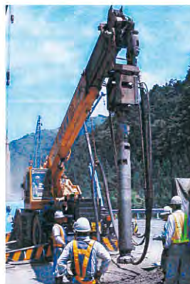
キャッチホーク式掘削機
