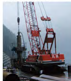
中掘ダウンホール削孔状況
