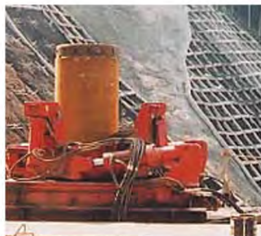
半揺動(チューピングジャッキ)でケーシングチューブ掘削
