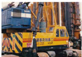
三点杭打機 3台
