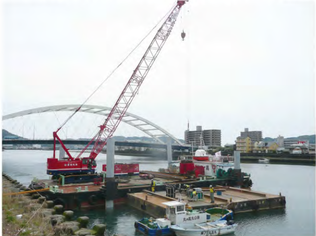
高知県 鏡川 地震高潮対策工事
