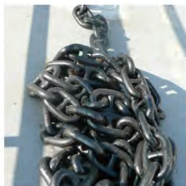
アンカ設置(チェーンアンカー工法) 宮地商事(株)
