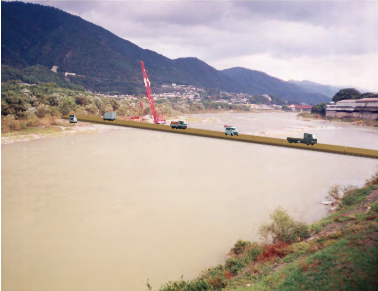
フロート船の活用 南海トラフの巨大地震に備えて強度な堤防補強の実施 鋼矢板打込
