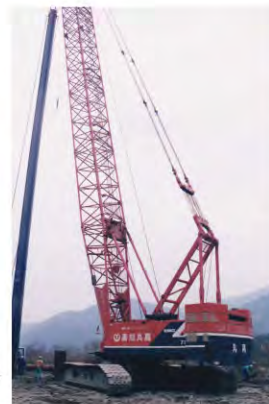
大型クローラークレーン 11台
