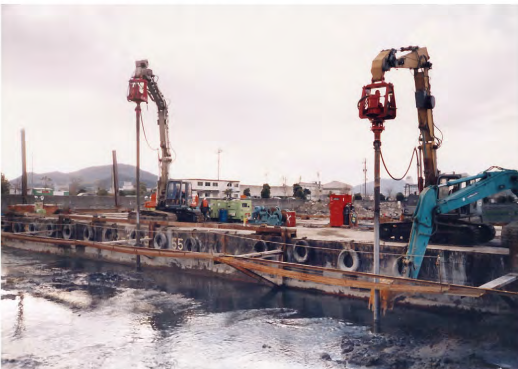
河川での地盤改良
