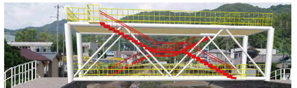
橋梁上に避難タワー(一般橋併用避難所)
