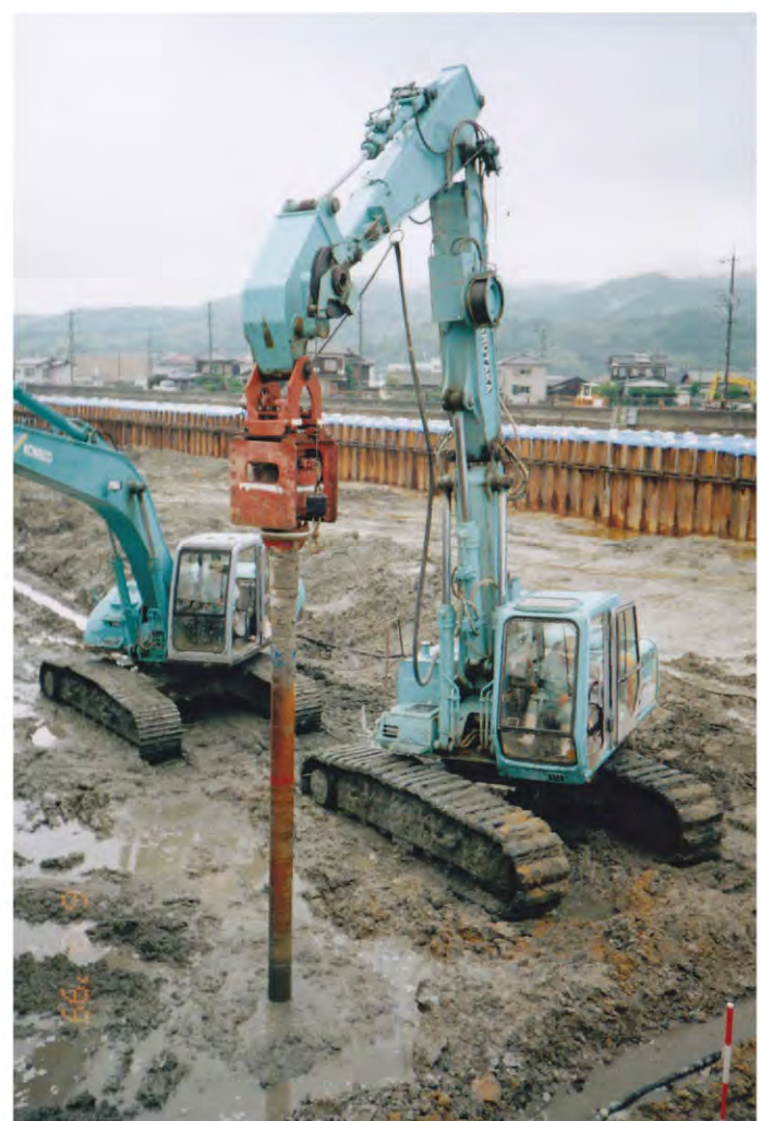
陸上部での地盤改良
