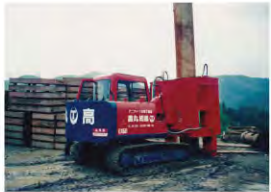
クローラークレーン 4台
