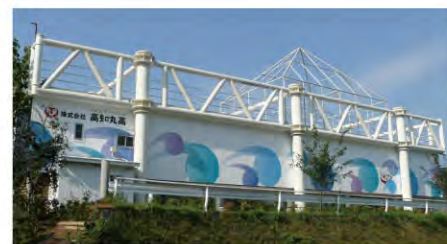
鋼管杭式避難タワー
