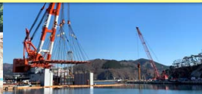
岩手県 大船渡 国内初の海底設置型 フラップゲート式水門の基礎工事
