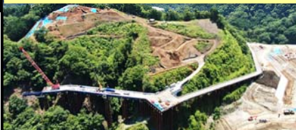
神奈川県 新東名新河内川橋工事 国内最大級の特種アーチ橋
