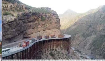
パキスタン 国道N70号線改修工事
