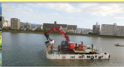
高知県 鏡川流出車両引上げ作業
