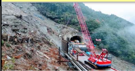
高知県 立川橋復旧工事
