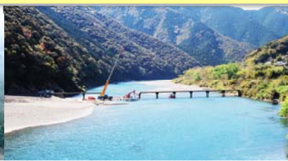
高知県 四万十岩間沈下橋復旧工事
