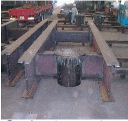
① 上部パネル工場製作 top panel factory production
