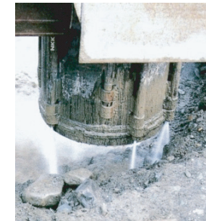
先行杭 Preceding guidance pile
