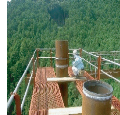
④ 支持杭杭頭切断 processing pile head
