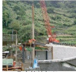
④ 支持杭打設 drilling bearing pile
