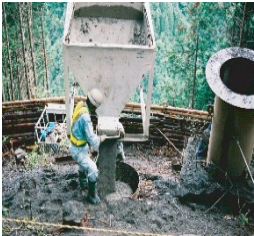
⑤ 根固モルタル打設 pouring mortar
