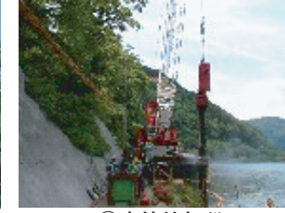
② 支持杭打設 drilling bearing pile
