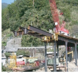
③ 上部パネル現場架設 top panel site construction
