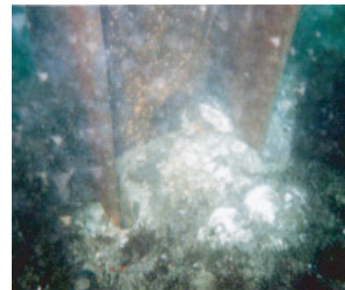
水中テトラポット貫入状況 Underwater tetrapod intrusion situation
