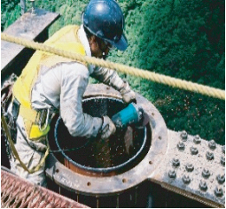
⑥ 杭頭部処理 processing pile head
