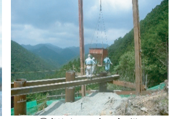
③ 根固モルタル打設 pouring mortar
