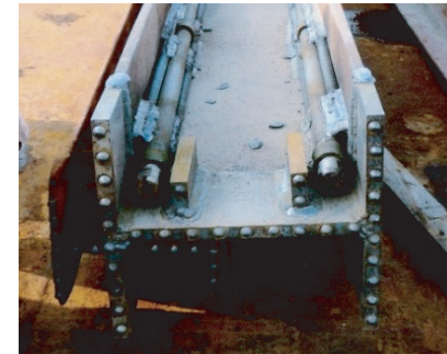
H型钢 先行ジェット・エア配管例 H steels preceding jet/air tube
