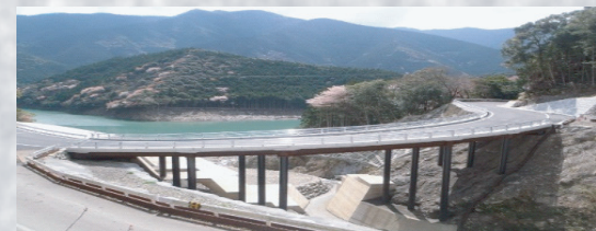
高知県：国道493号線道路災害復旧工事 Kochi/National Highway 493 Line road disaster restoration work
