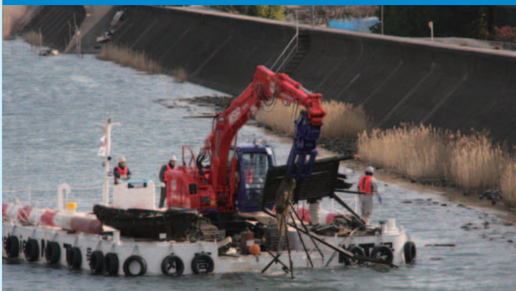
流木材撤去工事 Driftwood removal
